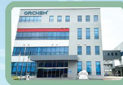
06月 办公楼4层完工
