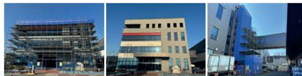
增建事务大楼四楼和连廊
