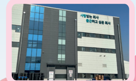
03월 생산동 미션 간판 신규 설치
